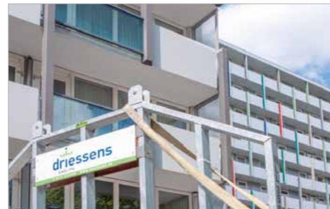
Рынок будущего: Реконструкция фасадов
