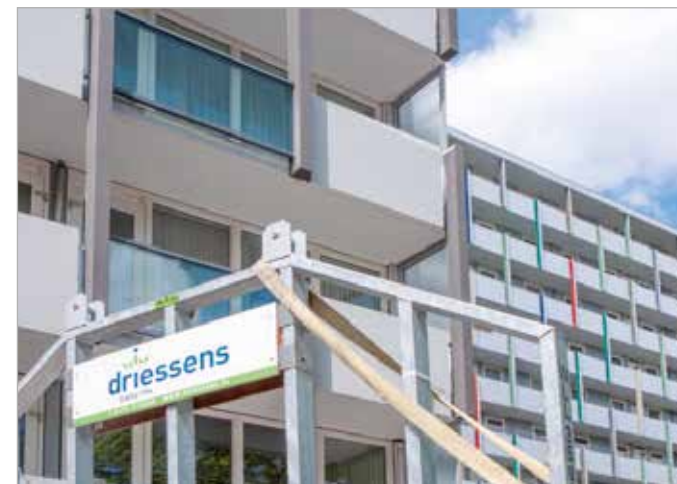
Tržište budućnosti: sanacija fasada
