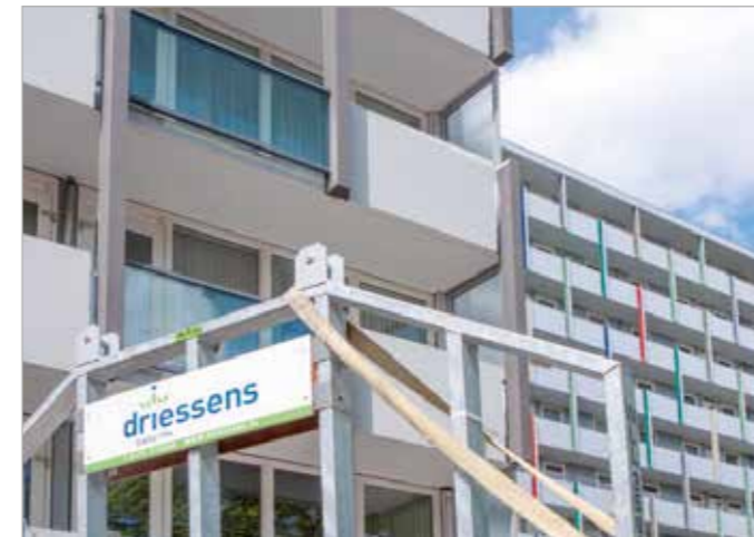
Tržište budućnosti: Sanacija fasada
