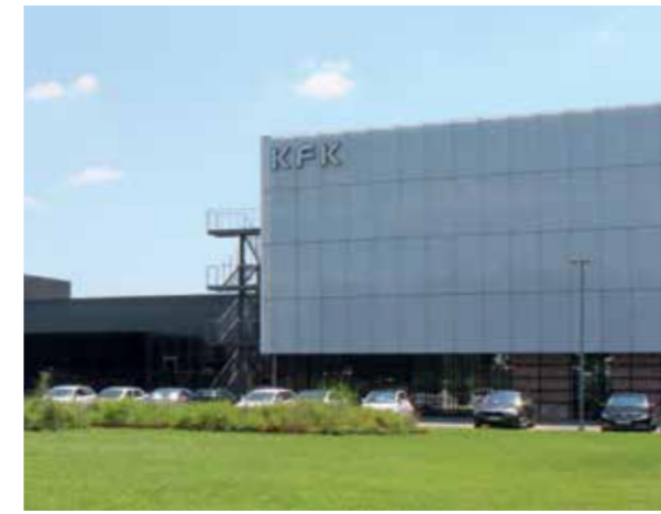
Este exitoso cliente de elumatec tiene su sede principal en Rugvica cerca de Zagreb.
