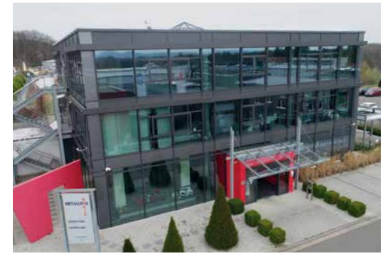
Harig es una empresa constructora metálica con sede en Bexbach, distrito de Sarre-Palatinado, y con representación en dos ubicaciones.
