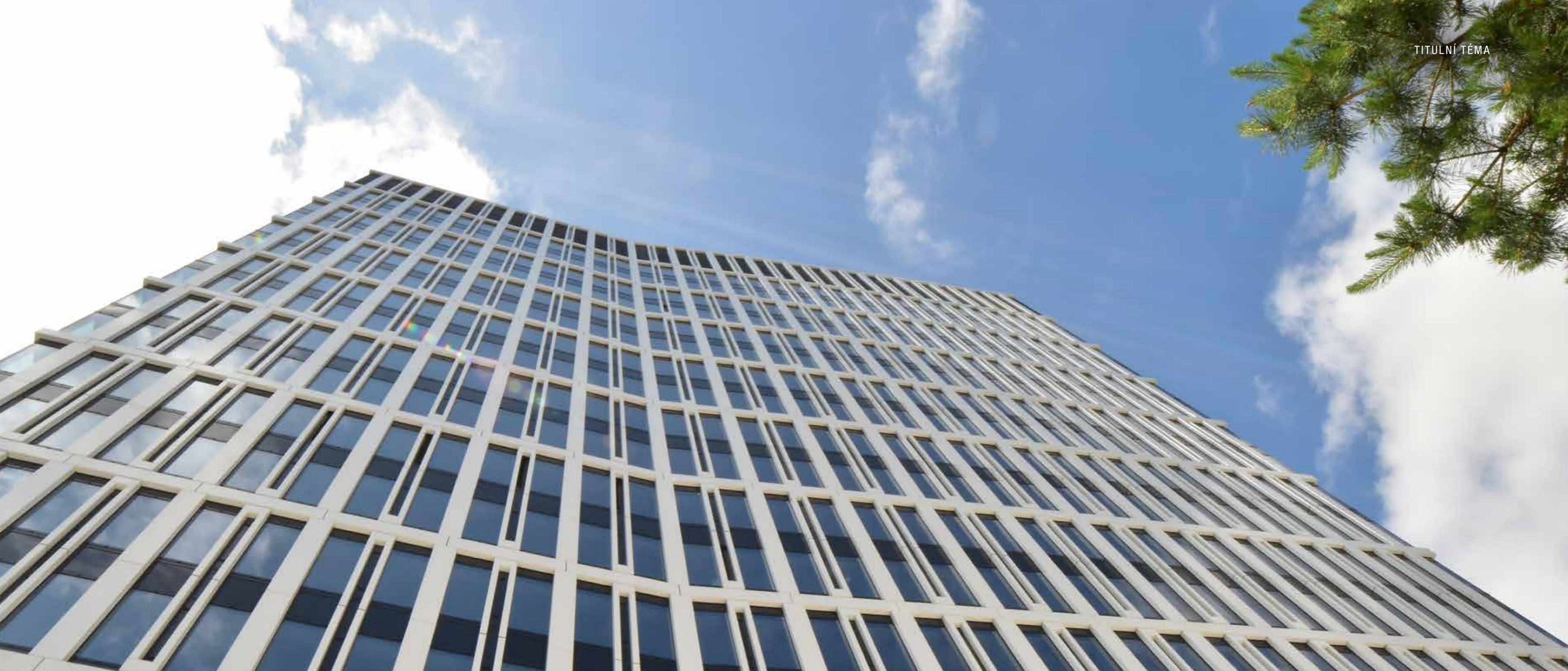
Fasádu frankfurtské věže St. Martin Tower vyrobila a smontovala firma KFK.
