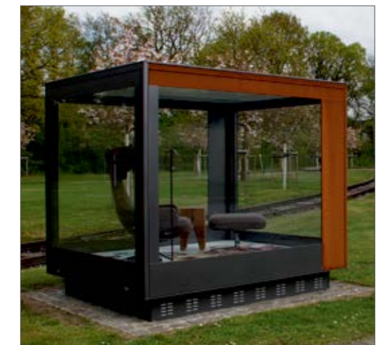
Indywidualna witryna bulwarowa z elementami wykonanymi ze stali o podwyższonej odporności na warunki atmosferyczne.
